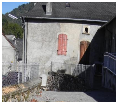
Réhabilitation appartement instituteur
